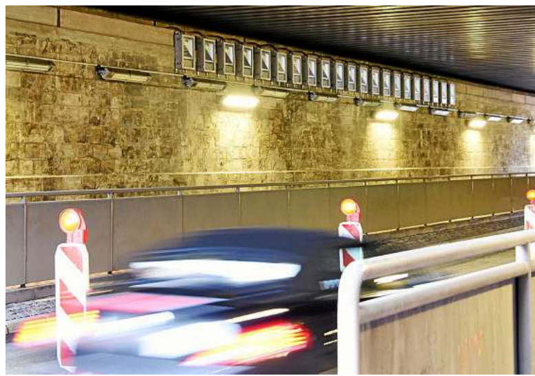
Eine Tageslichtbeleuchtung erhält in den kommenden Wochen auch die Bahnunterführung im Verlauf der Ettersburger Straße.
